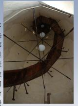
墙壁向上延伸约28米。阶梯采用的木材包括橡木、白杨和云杉。整个楼梯结构依靠精巧的铁架支撑,而后者早已显示出疲劳老化的迹象,因此市民塔在近期安装了22套新的托架,其设计方式可确保在不改变原有结构的情况下方便地拆除。从外部看,八扇极富特点的尖顶窗有四扇已经用砖块封堵。根据历史记录,该楼层在1501年地震后进行过加固,当时整个外部石墙进行了全面加固以确保塔身稳固。为了加固结构并防止倾斜的石板滑落,16世纪时,尖塔顶的金字塔部分还安装了一系列放射状金属支架,塔楼的地窖中央还留存着这种锁链结构。不过,两种系统均不能做到完全可靠,因此又在2010年新增了两个外部 箍圈。
